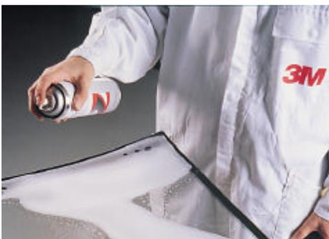
Jede Oberfläche ist prinzipiell als verschmutzt zu betrachten. Die zu verklebenden Oberflächen müssen sauber, trocken und fettfrei, d.h. frei von Staub, Schmutz, Fett, Öl, Oxiden, Trennmitteln und anderen Verunreinigungen sein. Dies erreicht man wie folgt:
